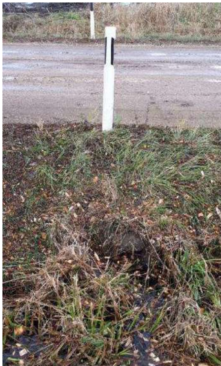
Foto 2. Vältitööde aegne vaade truubi T1 sissevoolule, 31.10.2024.
